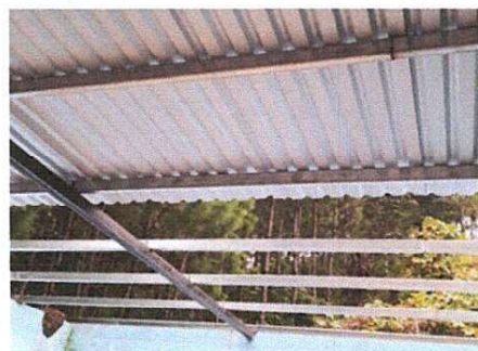
Foto 2: Instalación de techo. Aula 1.
