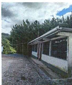
Foto 9: Instalación de canal. Aula 1 y 2. 13 ML
