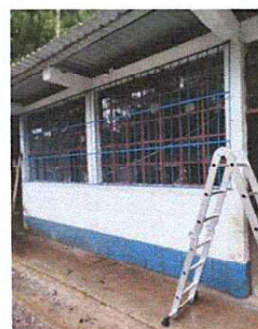
Foto 4: Instalación de balcones. Aula 1 y 2.
