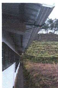
Foto 11: Instalación de canal parte posterior. Aula 3, 4, dirección y bodega. 20.50 ML.
