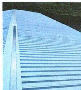
Foto 8: Instalación de techo. Aula 3, 4, dirección y bodega.
