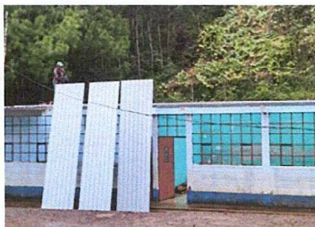
Foto1: Desmontaje y montaje de techo. Aula 1 y 2.
