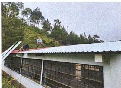
Foto 7: Desmontaje y montaje de techo. Aula 3, 4, dirección y bodega.
