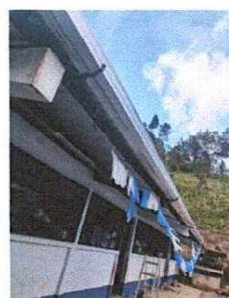
Foto 10: Sustitución de canal PVC por aluzinc. Aula 3, 4, dirección y bodega. 20.50 ML.
