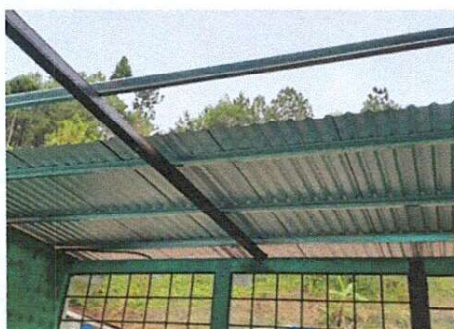
Foto 3: Instalación de techo. Aula 2.
